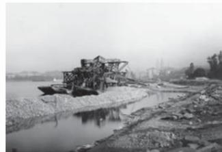
Aufschüttungsarbeiten am Utoquai um 1886: Insgesamt wurden für die ganzen Quaianlagen 1.24 Mio Kubikmeter Steinmaterial und Seeschlamm benötigt, die per Schiff herangeschafft und von eigens zu diesem Zweck entworfenen Baumaschinen eingebracht wurde. Ersichtlich ist die typische Vorgehensweise einen Damm aufzuschütten und ihn mit weniger stabilen Seekreide zu hinterfüllen.
