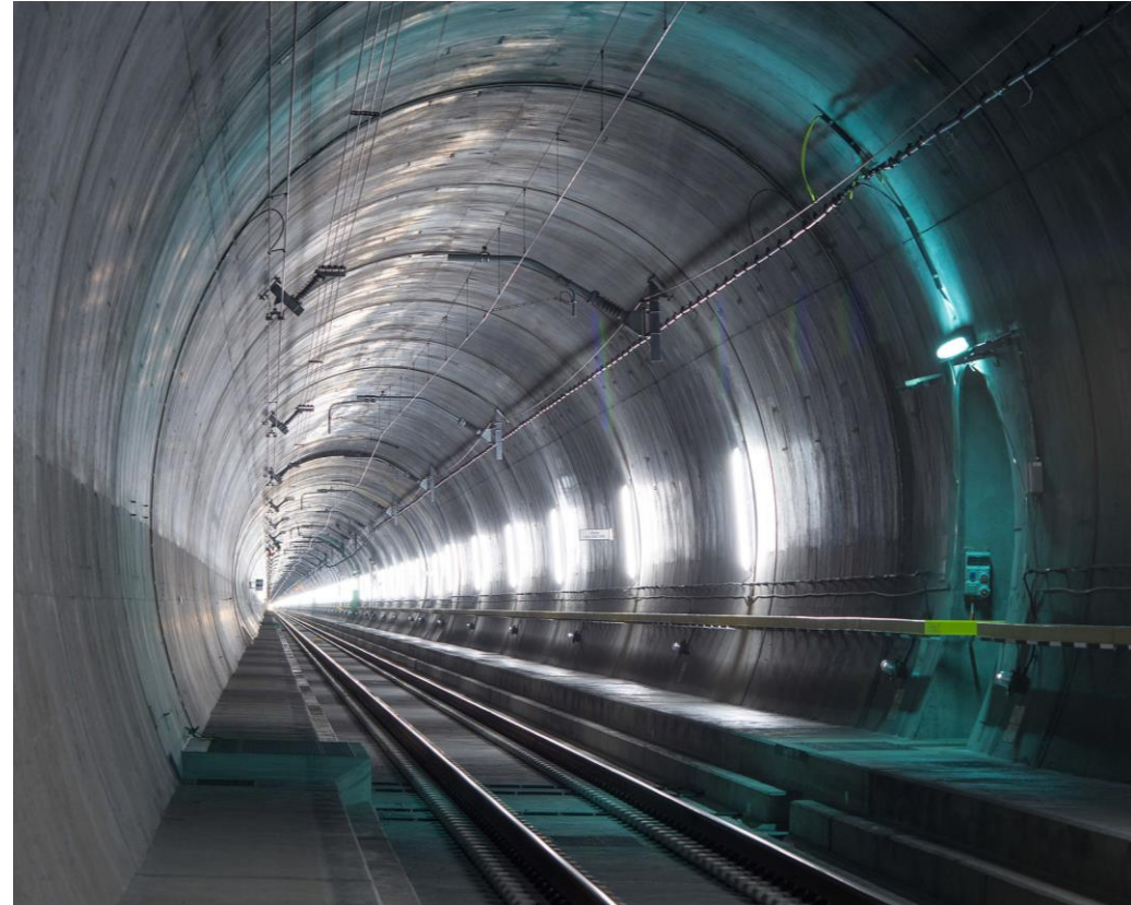
Abbildung 27: Tunnel des GBTs (Quelle: AlptransitGotthard AG, 2023).
