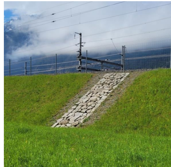
Abbildung 21: Trockenmauerstreifen (Aufnahme: Erismann, 2023).
