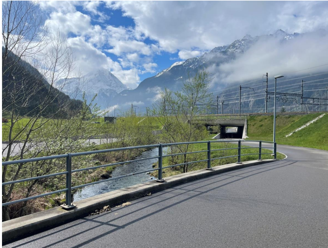
Abbildung 8: Unterführung Rynächt Durchgang für Fussgänger und Walenbrunnen (Aufnahme: Tamburini, 2023).
