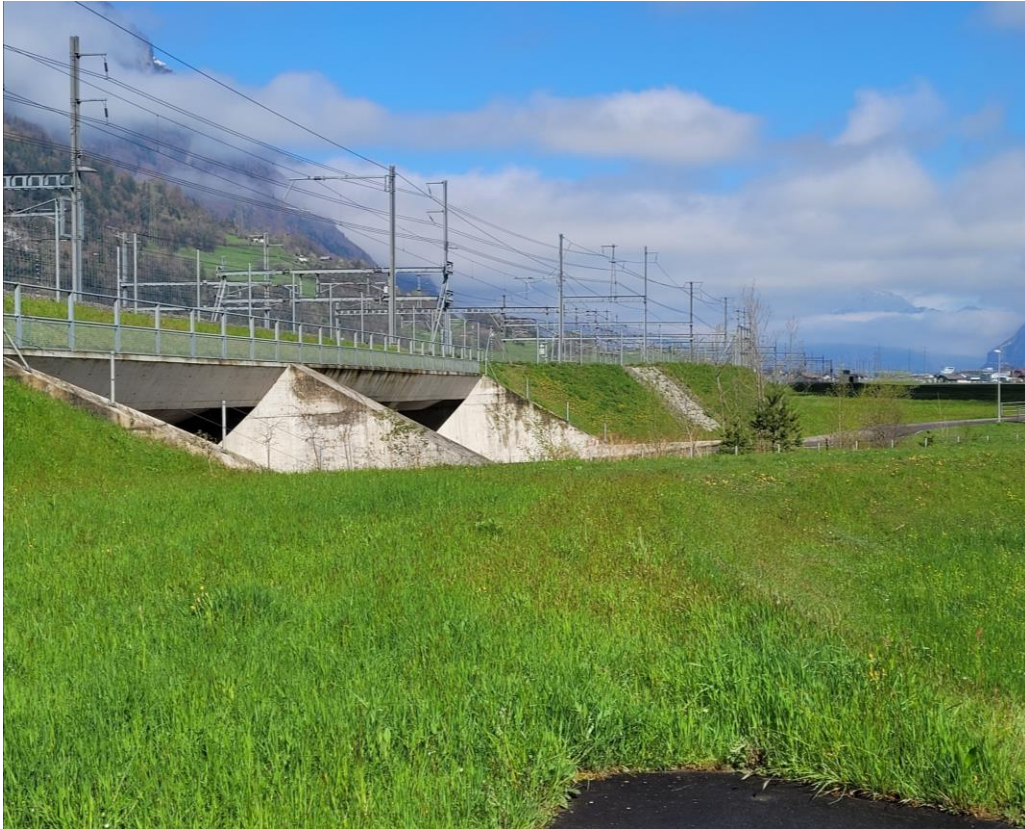
Abbildung 26: Bahndamm Zufahrtstrecke mit Unterführung Rynächt (Aufnahme: Erismann, 2023).
