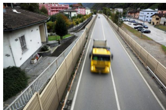
Abbildung 10: Schallschutzwände entlang der A13 (swissinfo, 2016)
