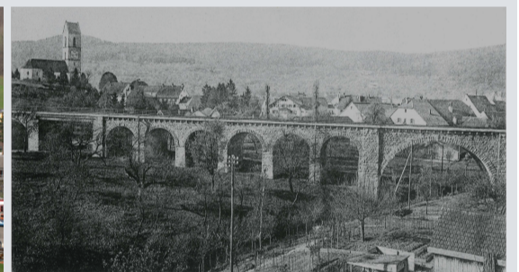
Der Viadukt von Gelterkinden mit Kirche und Dorf im Hintergrund, vorne die Ergolz
