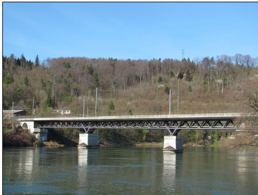
Abbildung 24: Die Aarebrücke wurde 2003 erneuert. EIGENE AUFNAHME.
