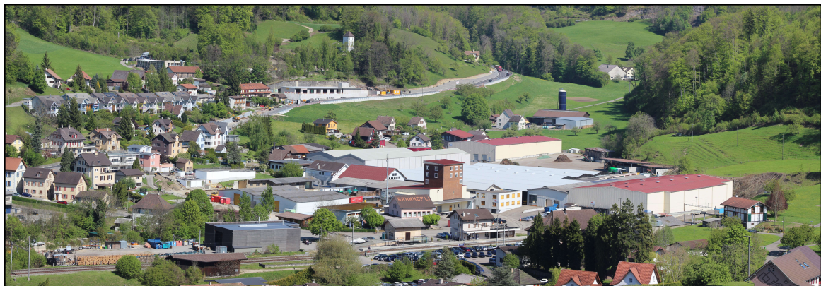
Abbildung 4: Aktueller Blick auf das ehem. Areal der Gipsfabrik hinter dem Bahnhof sowie oberhalb der Hauensteinstrasse. EIGENE AUFNAHME.
