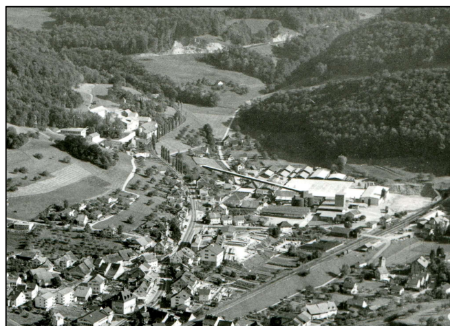
Abbildung 3: Luftbild mit Blick auf Läufe fingen. Links der Bildmitte ist der obere Teil der Gipsfabrik ersichtlich, in der Bildmitte der untere Teil. BALSCHKEIT, 2017.
