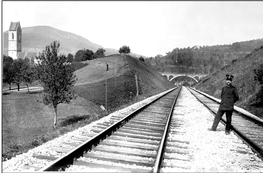
Abbildung 12: Markante Einschnitte in diverse Hänge kommen auf dem nördlichen Streckenabschnitt gleich fünf Mal vor. Hier: Kirchraimeinschnitt mit gewölbtem Strassenübergang. COLETTI, SPINNLER, 2013
