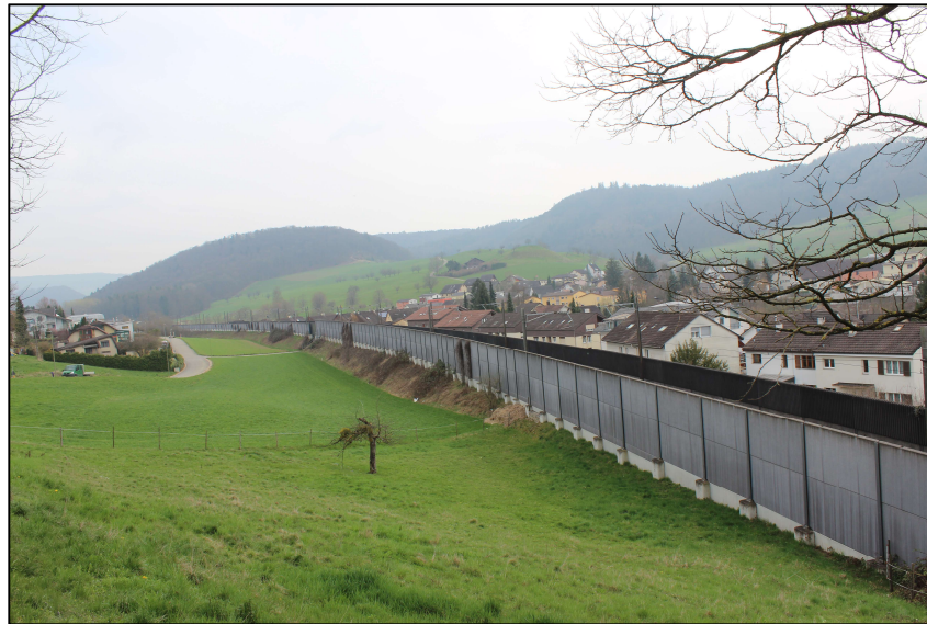
Abbildung 25: Die Sicht auf den Kirchraineinschnitt ist heute versperrt durch Lärmschutzwände. EIGENE AUFNAHME.
