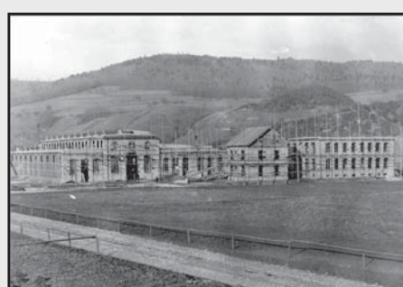
Erste Bauarbeiten auf dem BBC Areal, 1891
