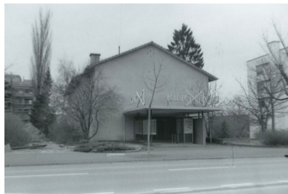
Abbildung 9: Ehemaliges Kino von Affoltern
