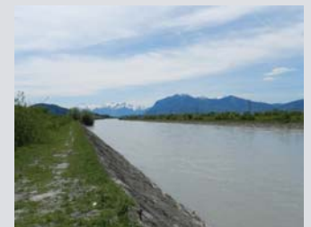
Der Durchstich bei Diepoldsau
