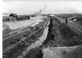
Arbeiten am Fussacherdurchstich 1896
