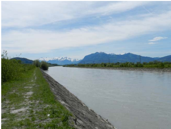
Abb. 11 Durchstich bei Diepoldsau mit Blick flussaufwärts Richtung Kriessern.
