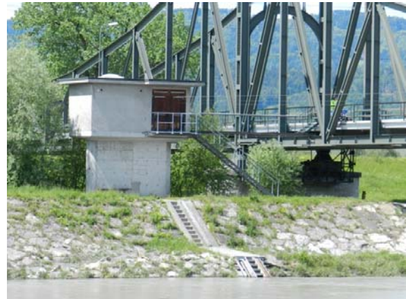
Abb. 12 Messstation zur Überwachung des Rheins bei der «Alten Rheinbrücke» in Diepoldsau.
