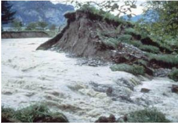
Abb. 4.16: Gebrochener Damm nach dem Hochwasser von 1987. (Basler 2008)
