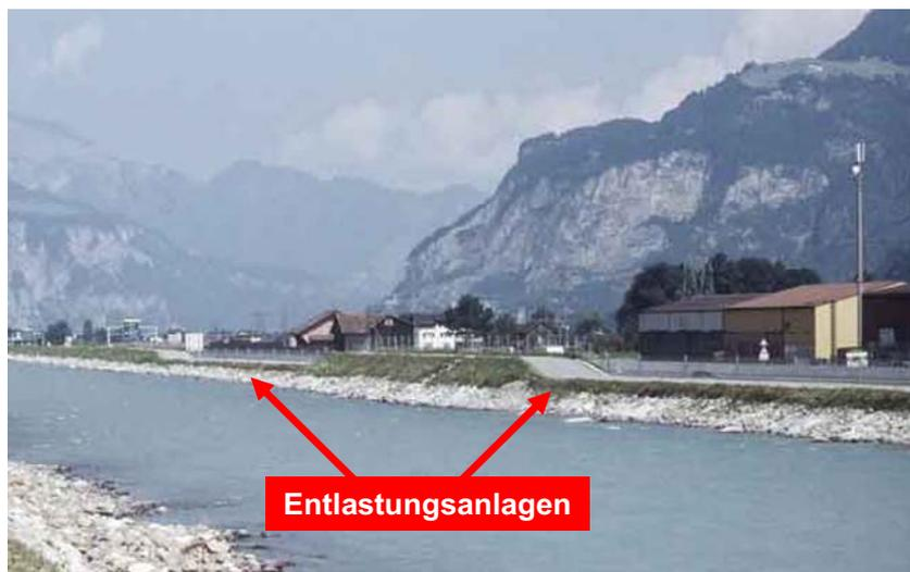
Abb. 4.18: Entlastungsanlage Altdorf. Der rechtsufrige Reussdamm zur Autobahn ist an dieser Stelle rund 1m tiefer und wird bei einem Hochwasser kontrolliert überströmt. (Basler 2008)
