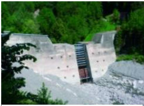
Abb. 4.12: Geschieberückhaltebecken im Schächen. (Baukader 2006)
