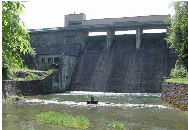
Abb. 15: Staumauer in den Schlagen (Sihlsee URL 2008)
