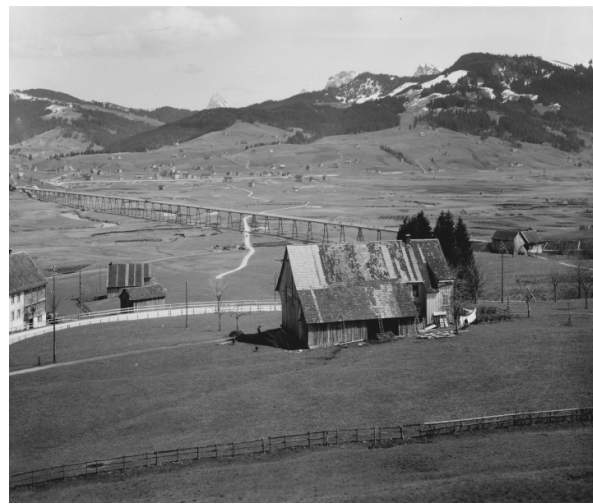
Abb. 13: Blick auf den Viadukt bei Willerzell (Etzelwerk 2008)
