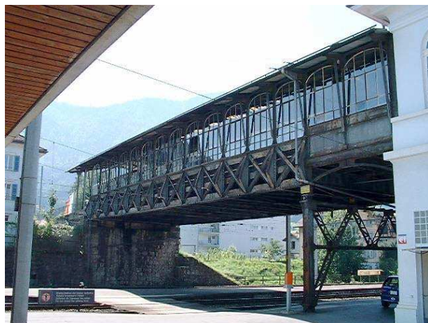
Abb. 14: Hochperron der Rigi-Bahn
