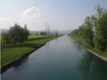
Linthkanal im Sommer 2006.
