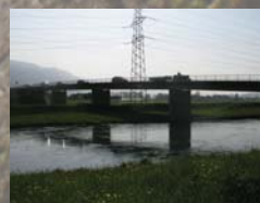
Strassenbrücke bei Benken.
