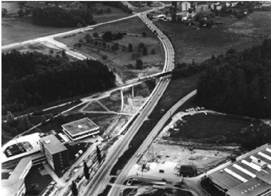
**Abb. 3.2:** Vorbereitungen für den Bau der Autobahn, 1963. Zuerst wird eine neue Hauptstrasse gebaut, dann die Autobahn entlang der damaligen Hauptstrasse (Abbildung 3.3). Links in der Mitte der Bahnhof Balsberg, links unten das Swissair-Verwaltungsgebäude.
