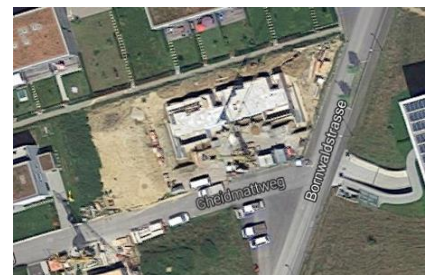
Abbildung 15 Gebäude im Bau (Screenshot aus Google Maps 2016)
